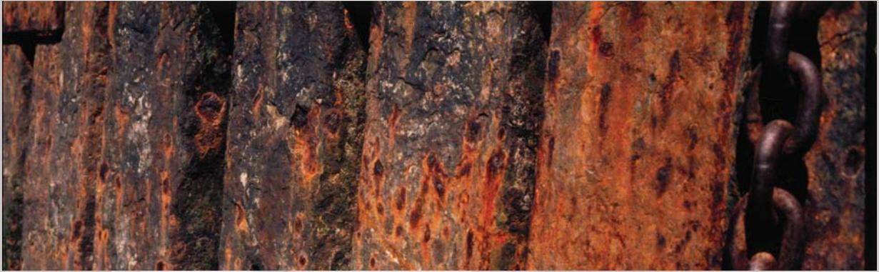
Columbuskaje vor der Sanierung 1985 – extrem korrodiert
