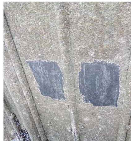
Intakter PUR-Korrosionsschutz nach 22 Jahren
